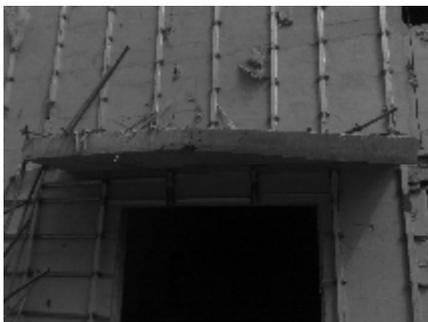
主楼三层钢筋混凝土悬挑雨棚严重变形
