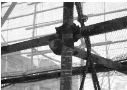
端部扣件盖板边缘至横向水平杆杆端的距离不应小于100mm
