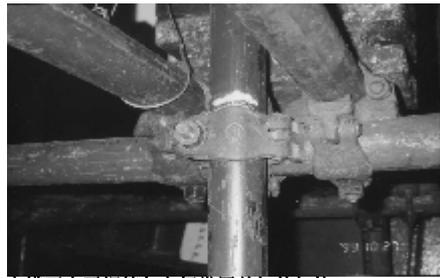
底模下水平钢管与立杆常用单扣件扣接
