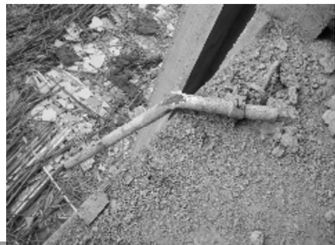
现场资料反映：西侧坍塌脚手架全长36m，是由总包方二次搭设，为扣件式钢管落地脚手架
