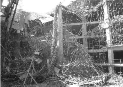
2005年9月5日晚10时10分，北京西西工程4#地项目中庭顶盖模板支在浇注接近尾声发生整体垮塌，酿成死亡8人、伤21人的特大伤亡事
