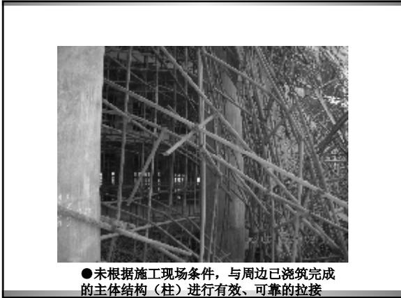
●未根据施工现场条件，与周边已浇筑完成的主体结构（柱）进行有效、可靠的拉接
