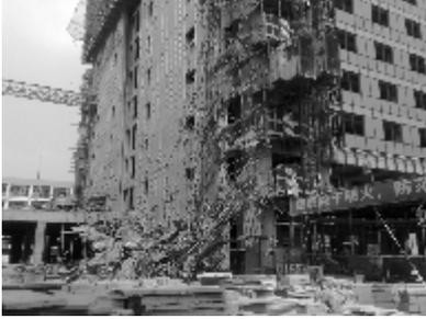
2010年8月30日上午9时许，无锡市北塘区文教中心工程主楼西立面落地脚手架在幕墙石材的堆放过程中，突然坍塌，造成3死5伤事故
