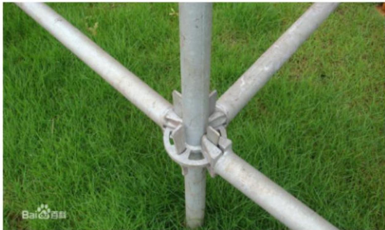
➤ **使用寿命长：**盘扣架一次性投资比传统扣件钢管架大（约为1.3~1.4倍），但盘扣架构件全部采用热镀锌防腐工艺，较传统扣件钢管架可提高10倍以上使用寿命。
